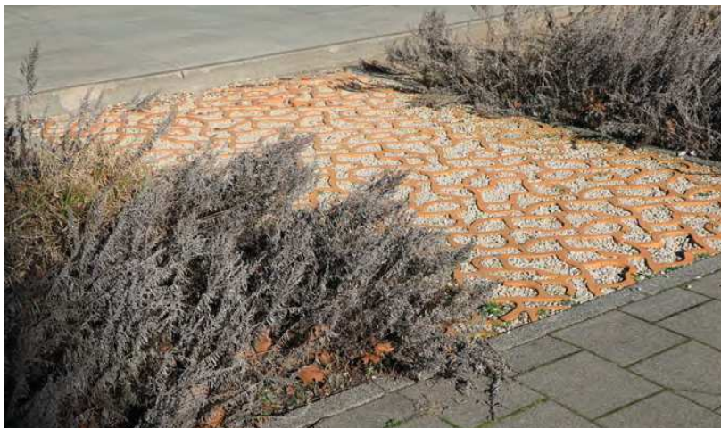
De Rain(a)way Flood tegels hebben een bergings- en infiltratiefunctie
